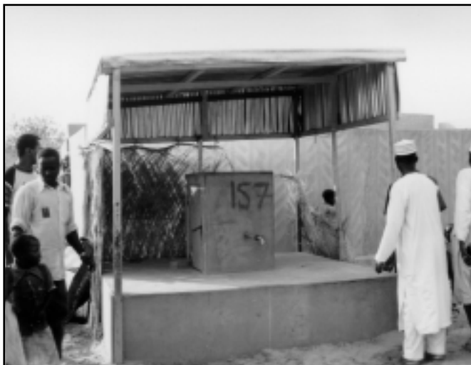
La semplice struttura dove arriva la condotta dell'acquedotto di Zinder.
